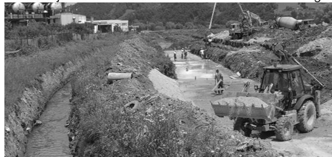
Radovi na uređenju korita rijeke Grabarske
